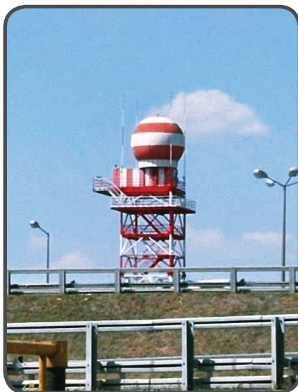
Фото 1.5. Метеорологический радиолокатор (метеорадиолокатор) МРЛ -5Б
